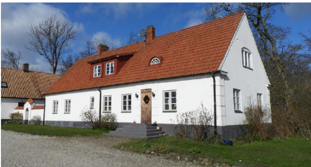
Flygelbyggnaden från söder. Foto: Olga Schlyter
