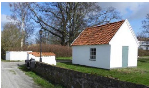
Grindstugan sedd från Vintriegårdsvägen i väster. Foto: Olga Schlyter
